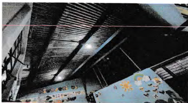
Foto 1: Sustitución de lámina en las tres aulas del edificio escolar.
