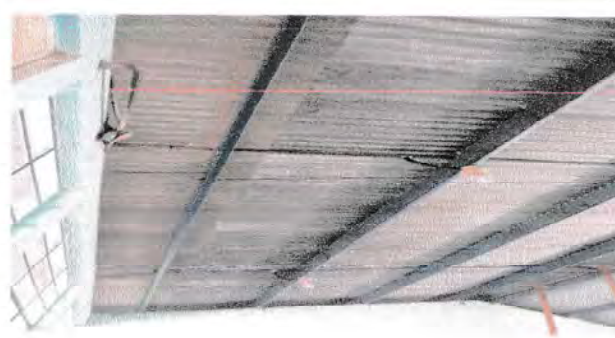
Foto 2: Sustitución de 100 laminas dañadas en las tres aulas del edificio escolar, por lámina troquelada.
