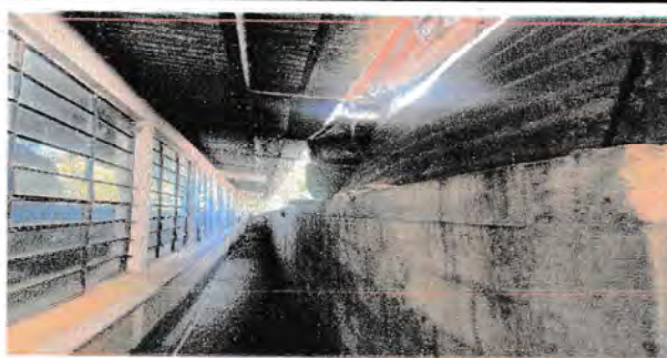
Foto 5: Reparación de muro perimetral de block con tubo hg y malla galvanizada, soleras intermedias y columnas en la parte posterior del edificio escolar.
